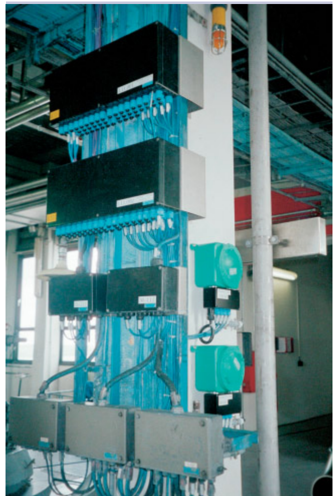
Bild 13: RIO-System in zentraler Anordnung.
