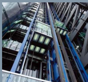
■ 电梯使用编码器确认轿箱楼层
