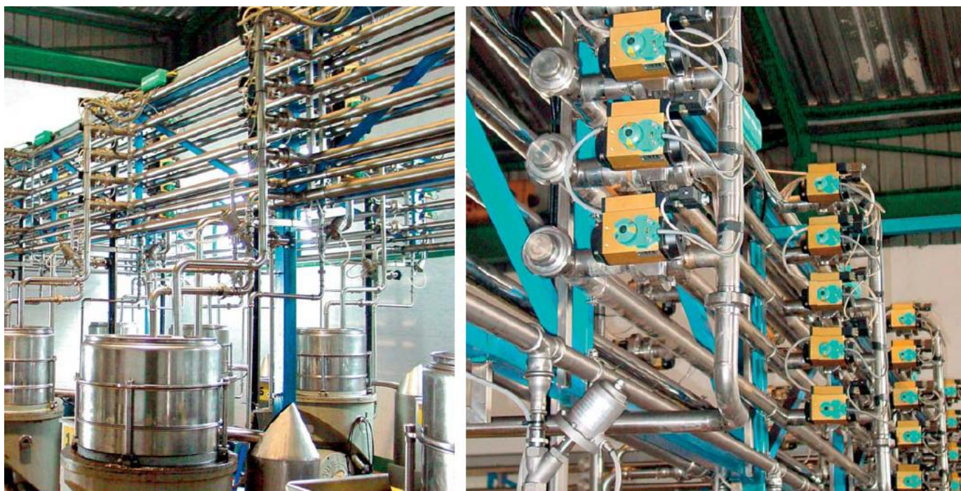
用AS-Interface控制很多阀门
