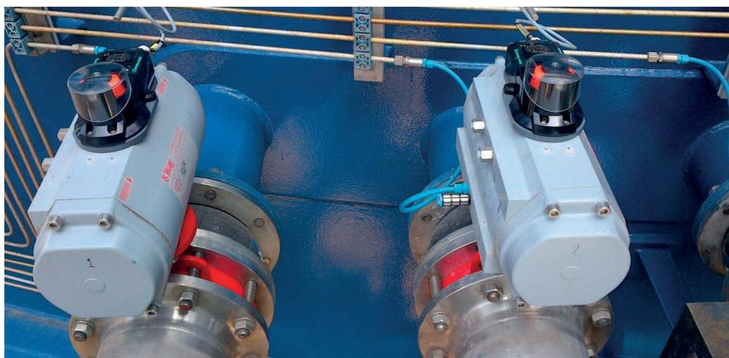
Der F31K2 lässt sich ganz einfach am pneumatischen Antrieb montieren
