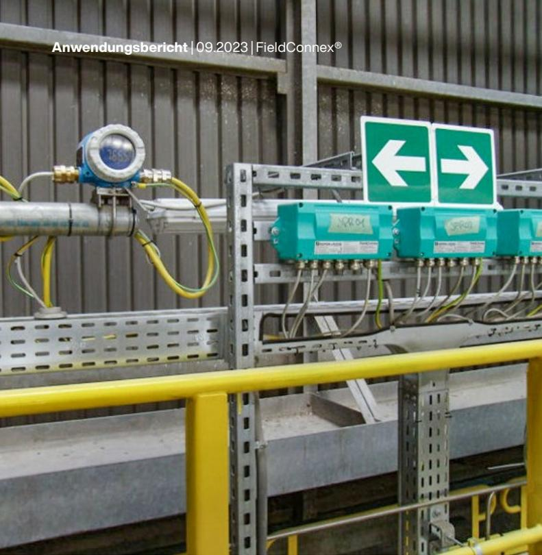
Einfacher Geräteanschluss durch Feldbarriere in der Nähe der Geräte
